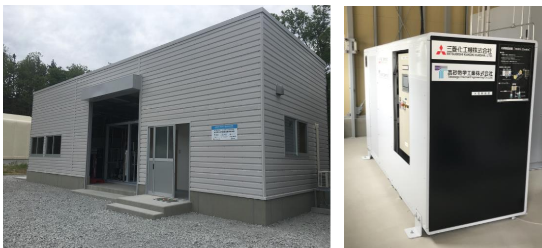
図2 実証サイトの外観(左)と、両社で開発した固体高分子形水電解装置(右)
