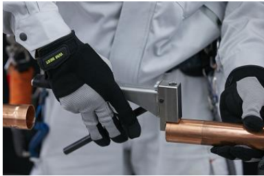
【写真4 窒素ガス封入口の穴あけ】
