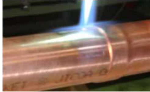
写真2 開口部より燃焼ガスを入れる
