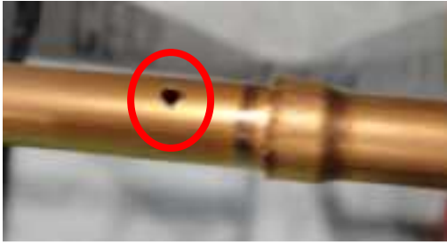
写真1 配管に円形の開口を専用治具にて開く
